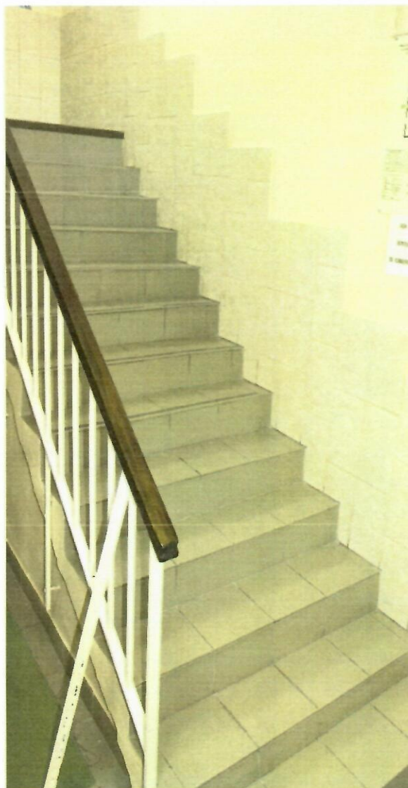
Лестница на 2 этаж
